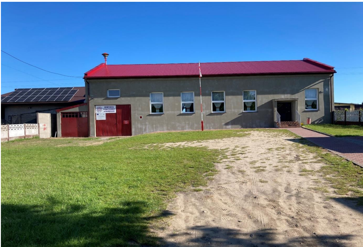
Termomodernizacja Remizy OSP Kalmuki
