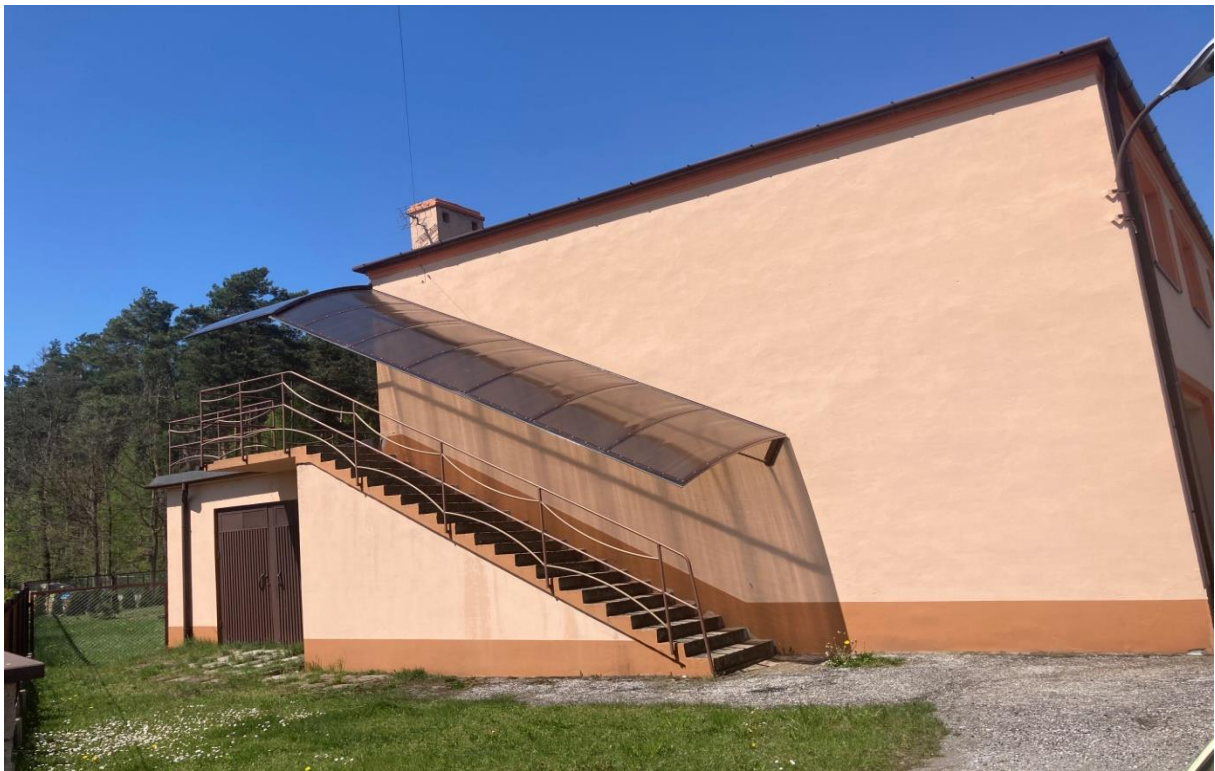
Wykonanie zadaszienia schodów przy OSP Cyganka
