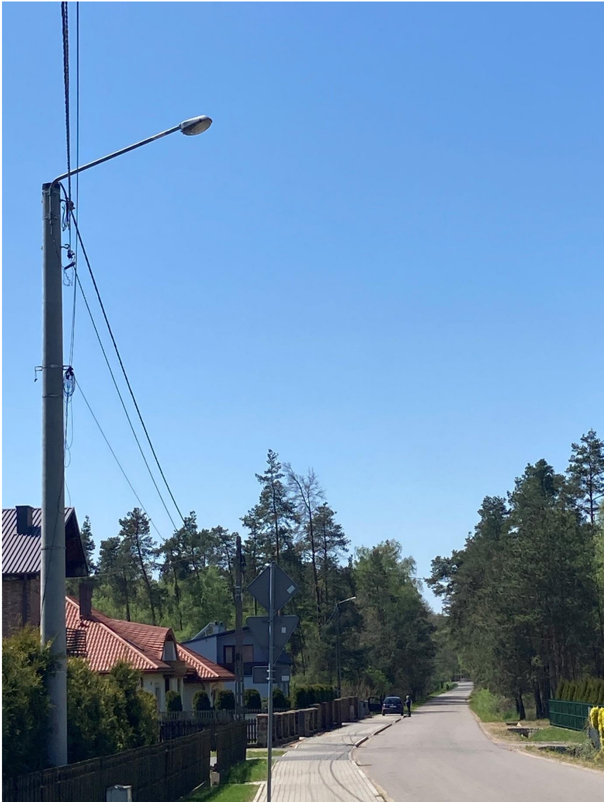
Montaż opraw oświetlenia LED i linii oświetleniowej w m. Cyganek
