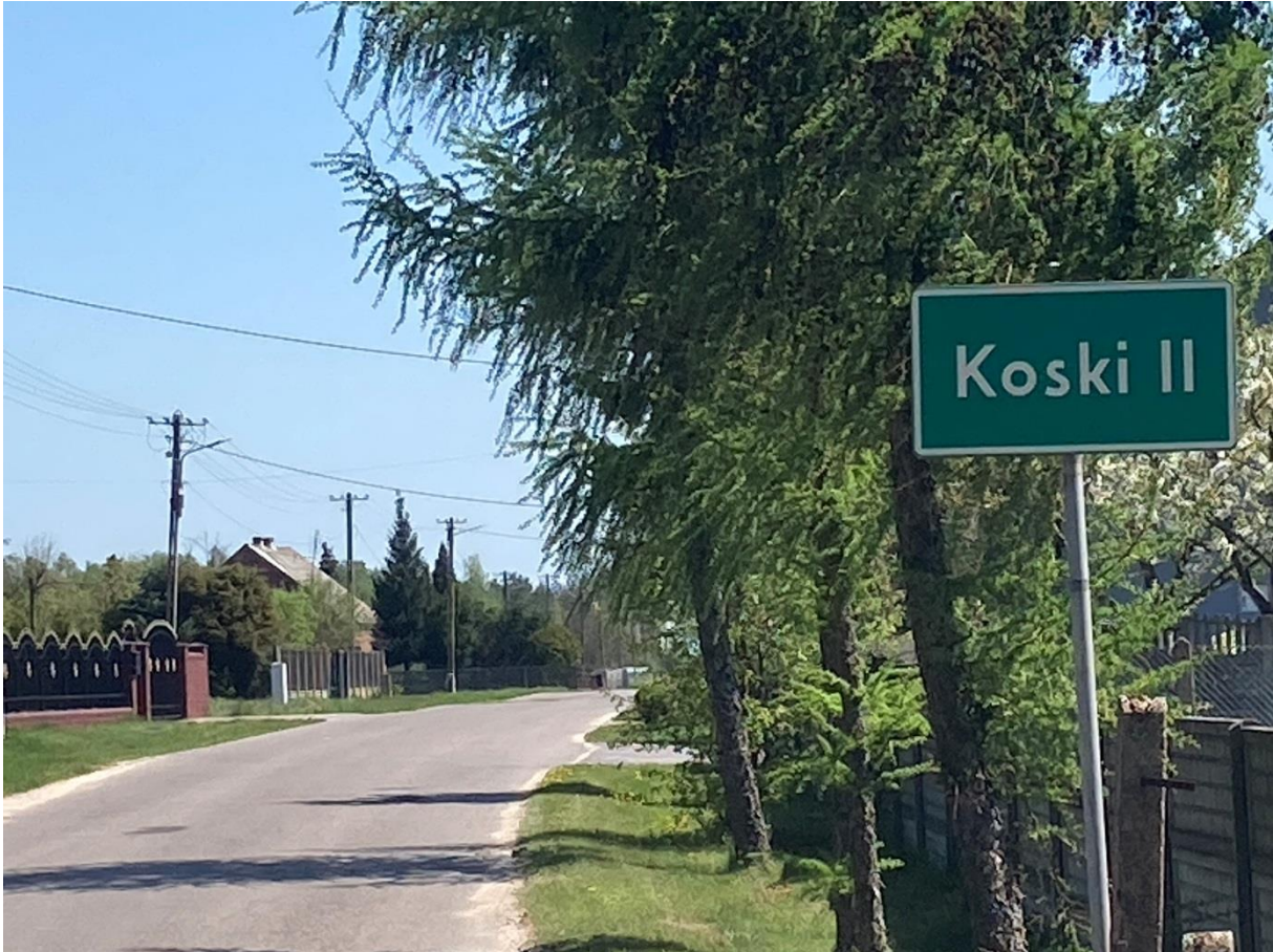
Koski – wymiana 13sodowych/rtęciowych opraw oświetlenia na nowe typu LED
