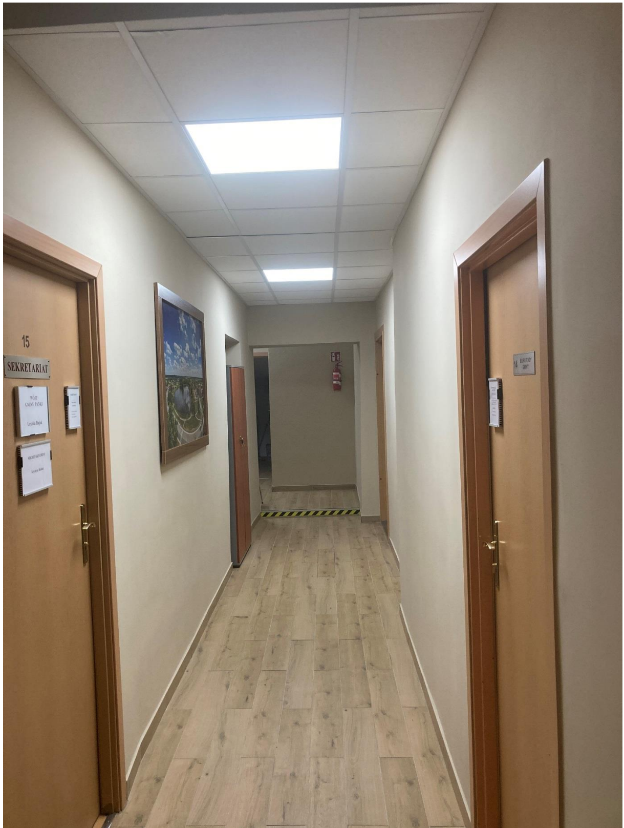
Remont korytarzy Urzędu Gminy – piętro
