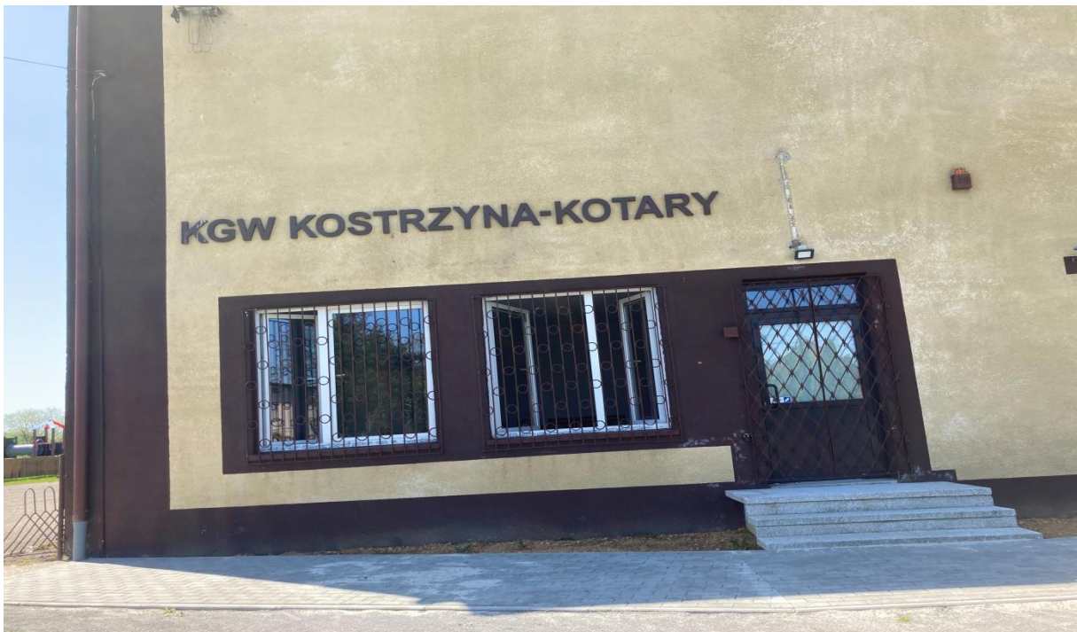
Wykonanie chodnika przy OSP Kostrzyzna
