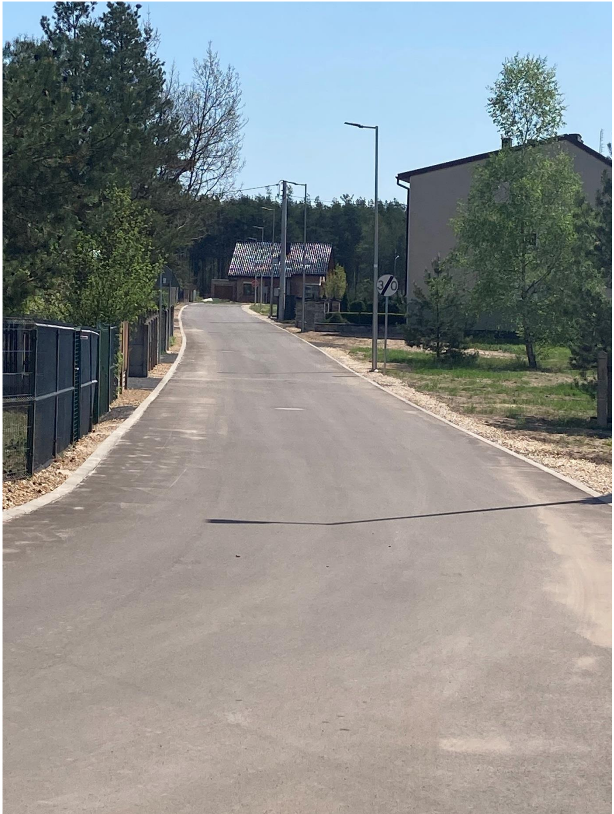
Budowa drogi nr 693016S w m. Praszczki wraz z budową oświetlenia
