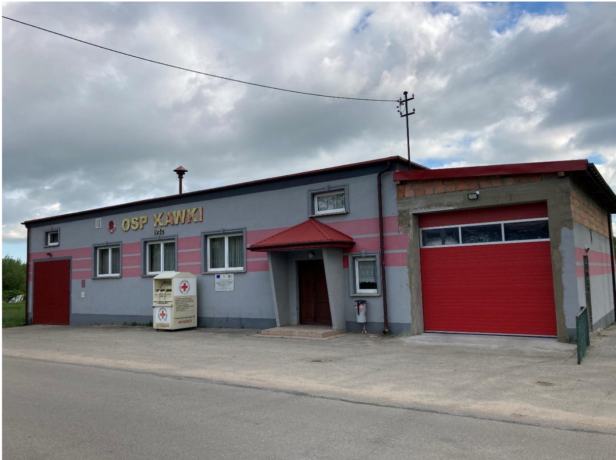
Modernizacja budynku strażnicy w Kawkach
