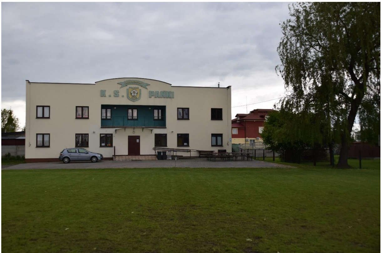
Budynek szatniowo-socjalny w Pankach ul. Częstochowska 13b
