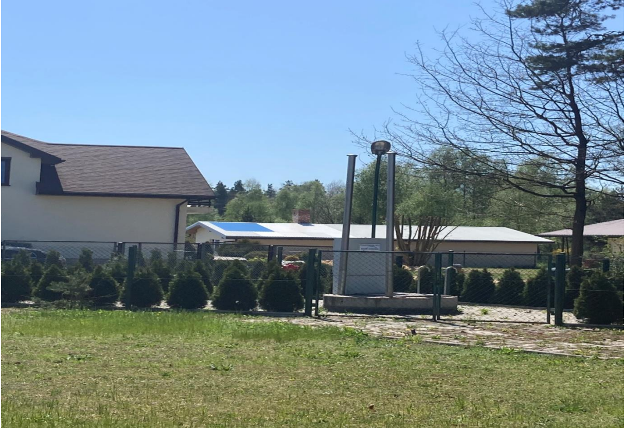
Zakup krzewów na przepompownię ścieków
