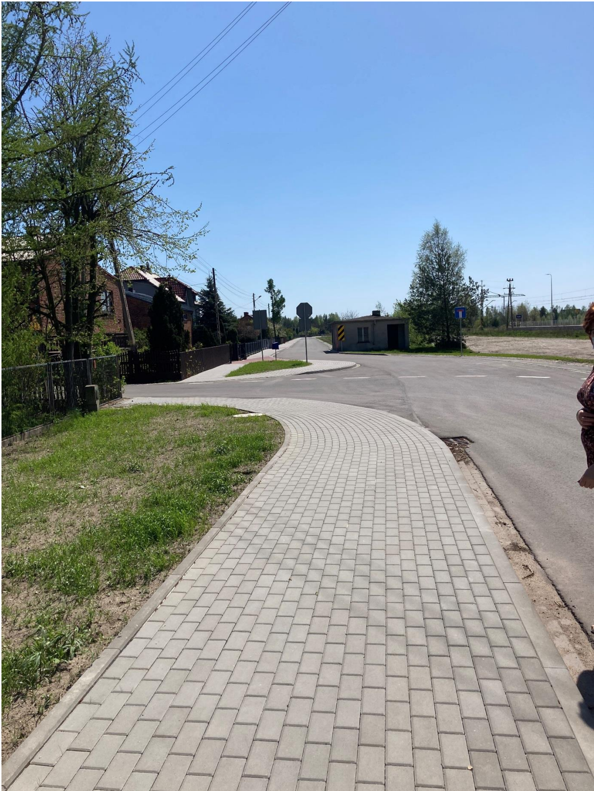
Przebudowa drogi nr 693023S ul. Dworcowa w Pankach
