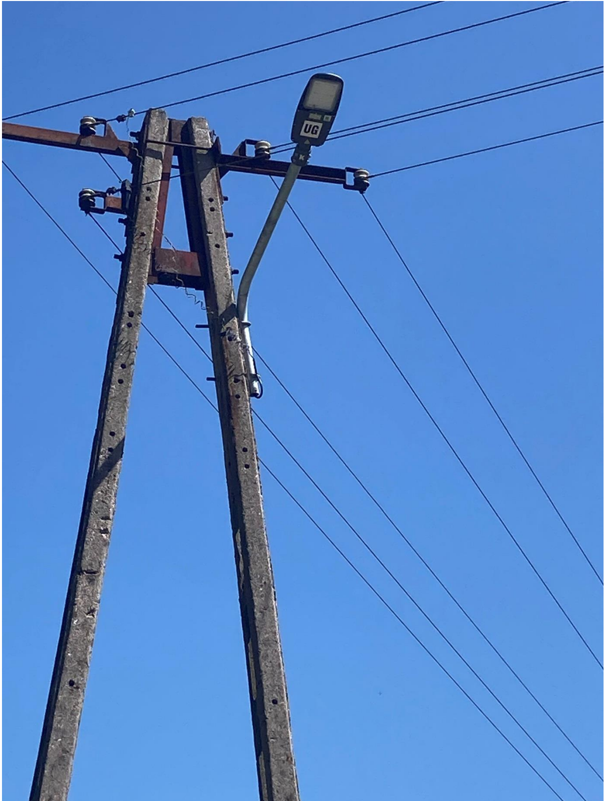
Koski – wymiana 13sodowych/rtęciowych opraw oświetlenia na nowe typu LED
