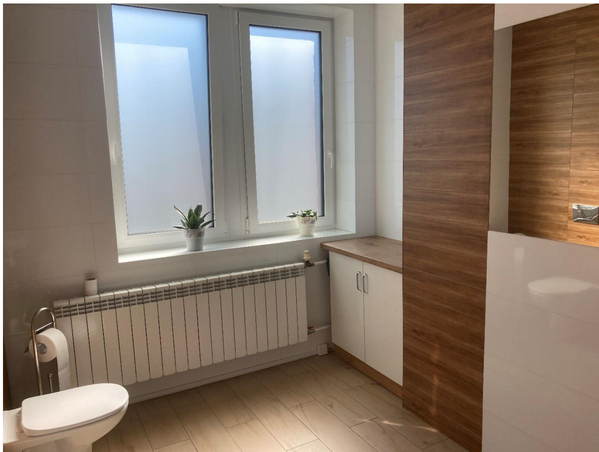
Remont łazienki w Urzędzie Gminy – piętro
