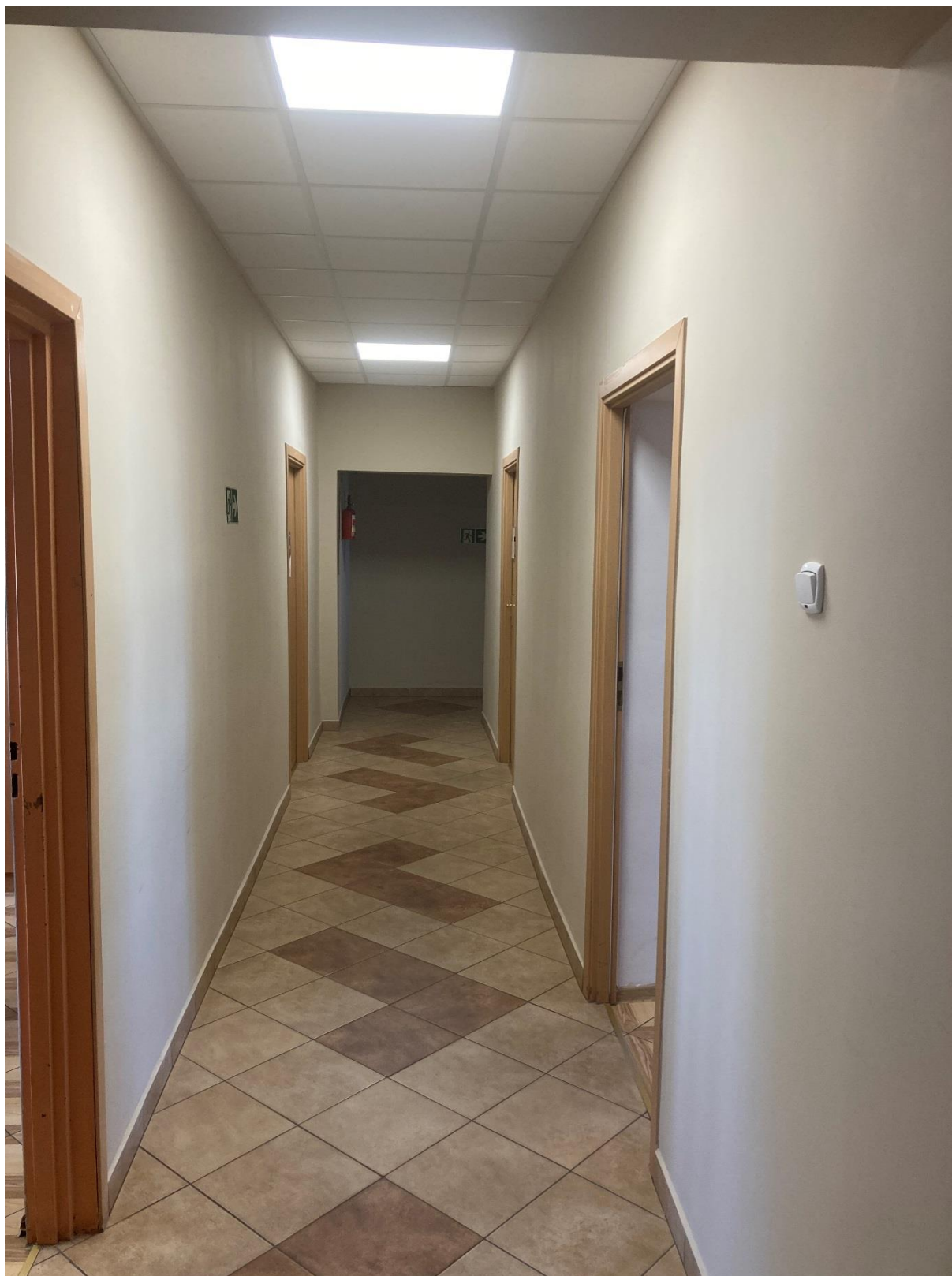
Remont korytarzy Urzędu Gminy – parter
