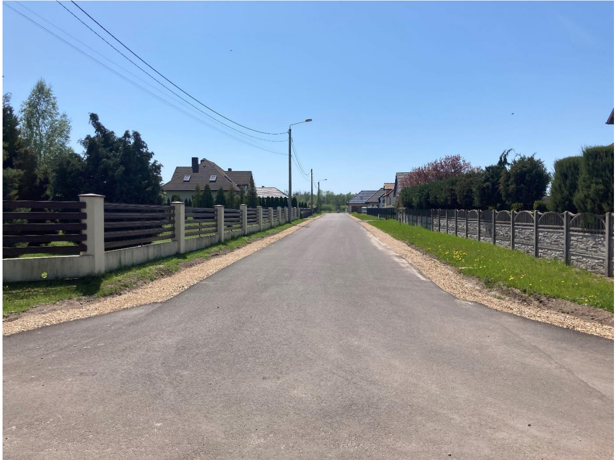
Przebudowa odcinka ul. Ogrodowej w Pankach
