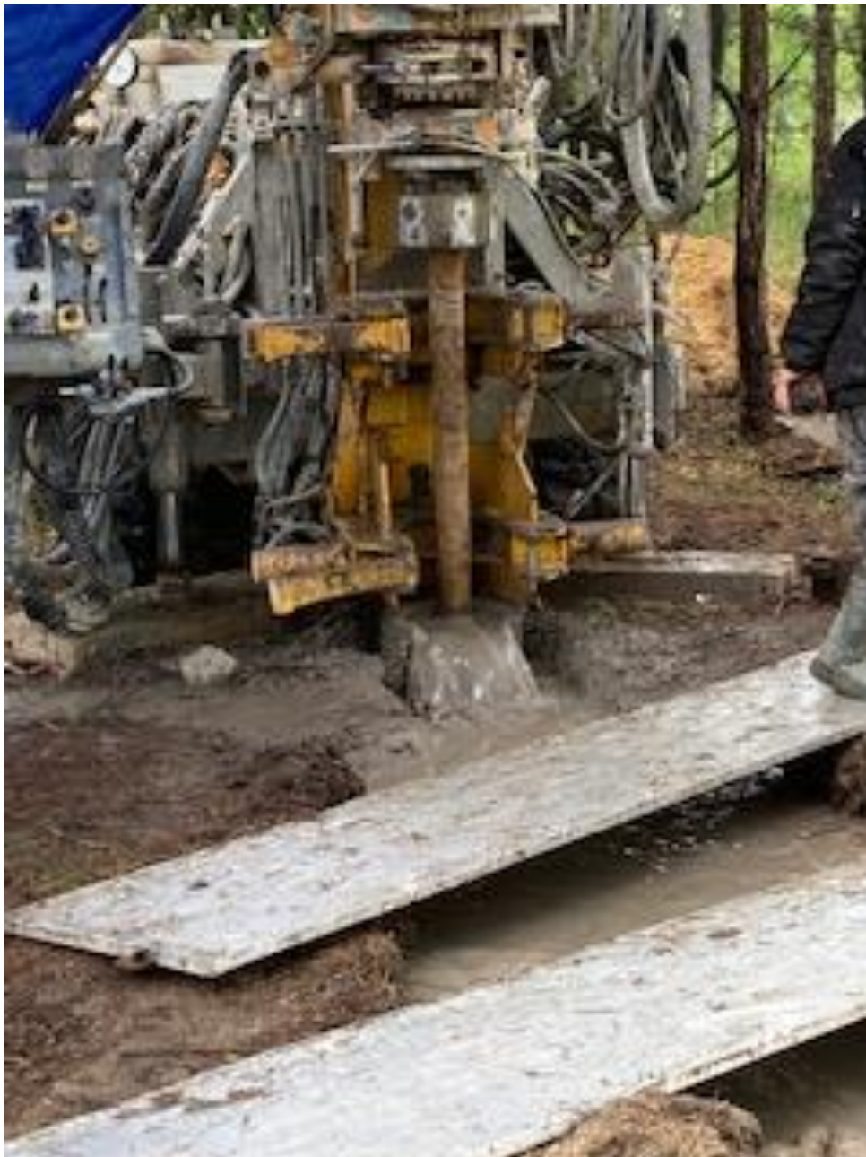
Rys. Odwiert studni głębinowej ujęcia wody przy ul. Dworcowej w Pankach
