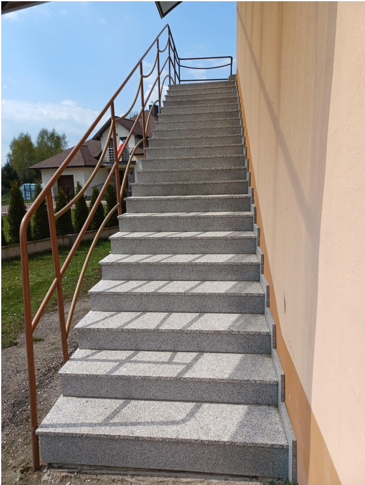
Rys. Położenie płytek na schodach przy wejściu do remizy OSP Cyganka
