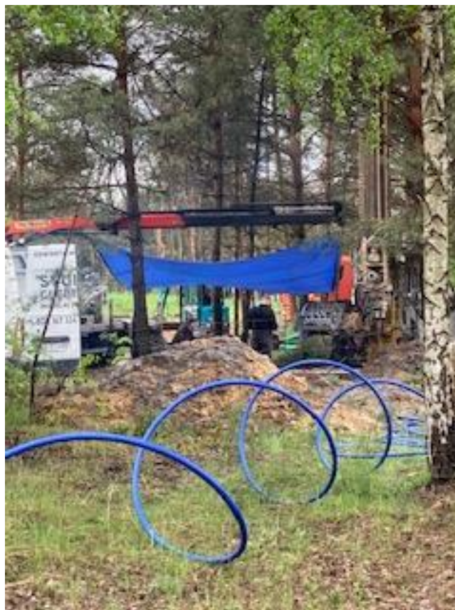
Rys. Prace związane z budową ujęcia wodny pitnej przy ul. Dworcowej w Pankach
