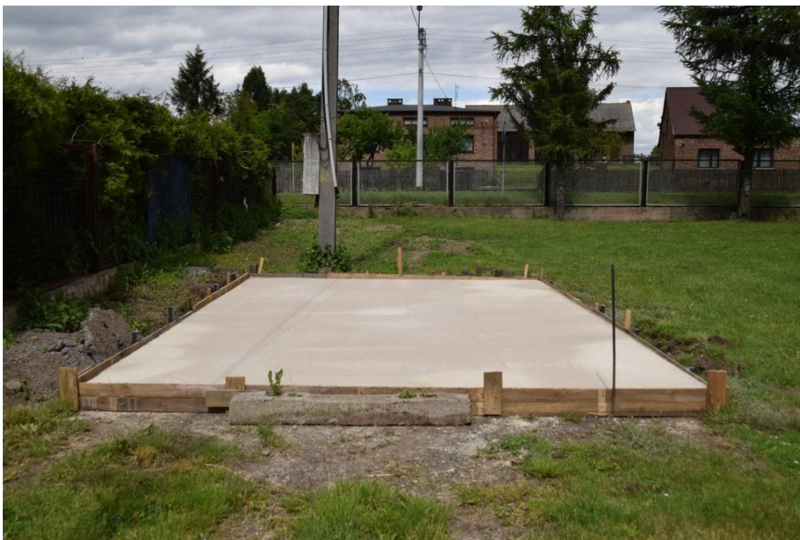
Rys. Betonowa wylewka pod nowy garaż metalowy na Boisku Piłkarskim przy ulicy Częstochowskiej 13 B w Pankach.
