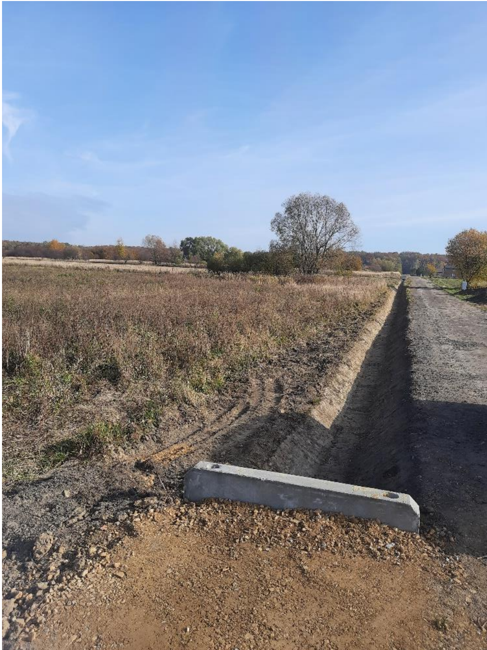
Rys. Przebudowa drogi w miejscowości Zwierzyniec III
