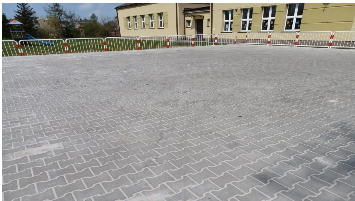
Rys. Wykonanie placu z kostki brukowej przy Szkole Podstawowej w Pankach
