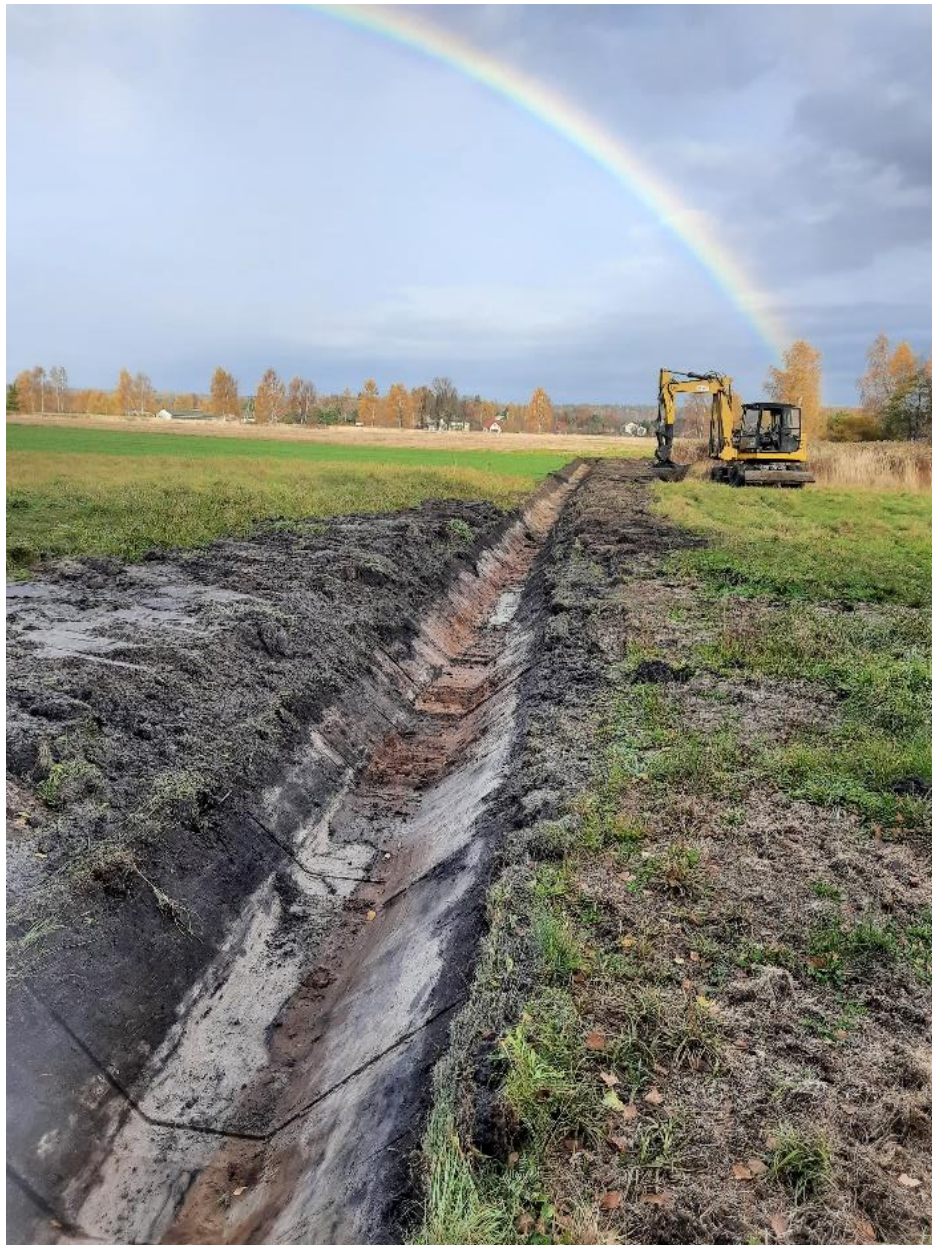
Rys. Odtwarzanie rowu melioracyjnego
