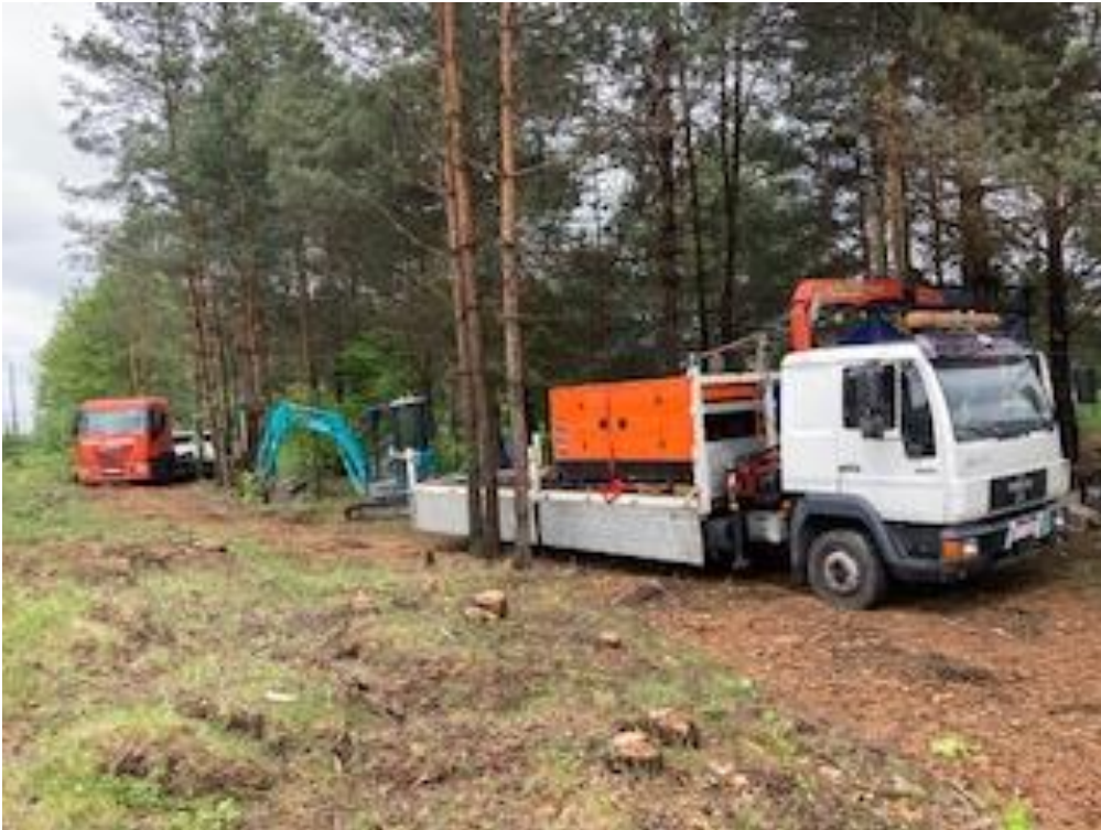
Rys. Prace związane z budową ujęcia wodny pitnej przy ul. Dworcowej w Pankach
