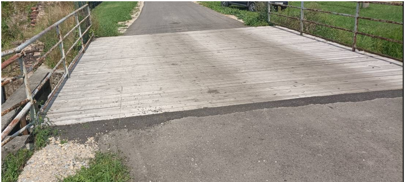
Rys. 3.5 Widok na dylinę pomostu
