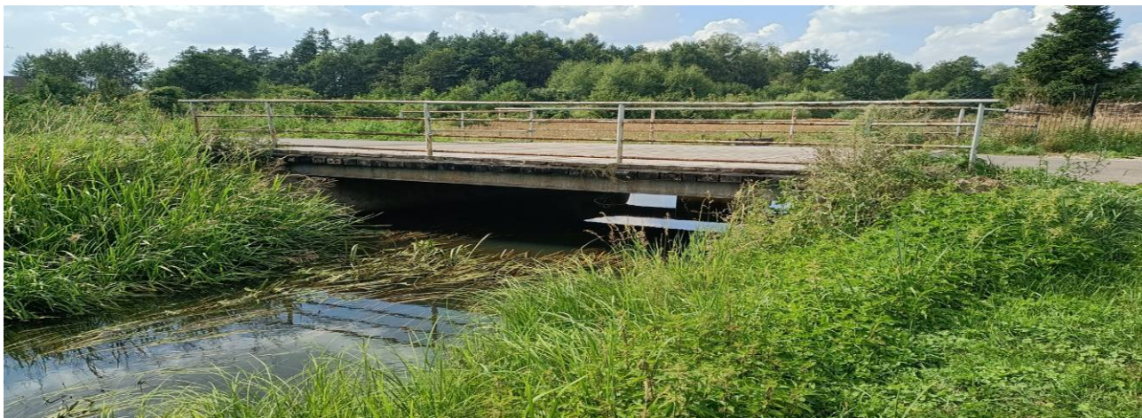
Rys. 1.1 Widok od strony wody górnej istniejącego mostu
