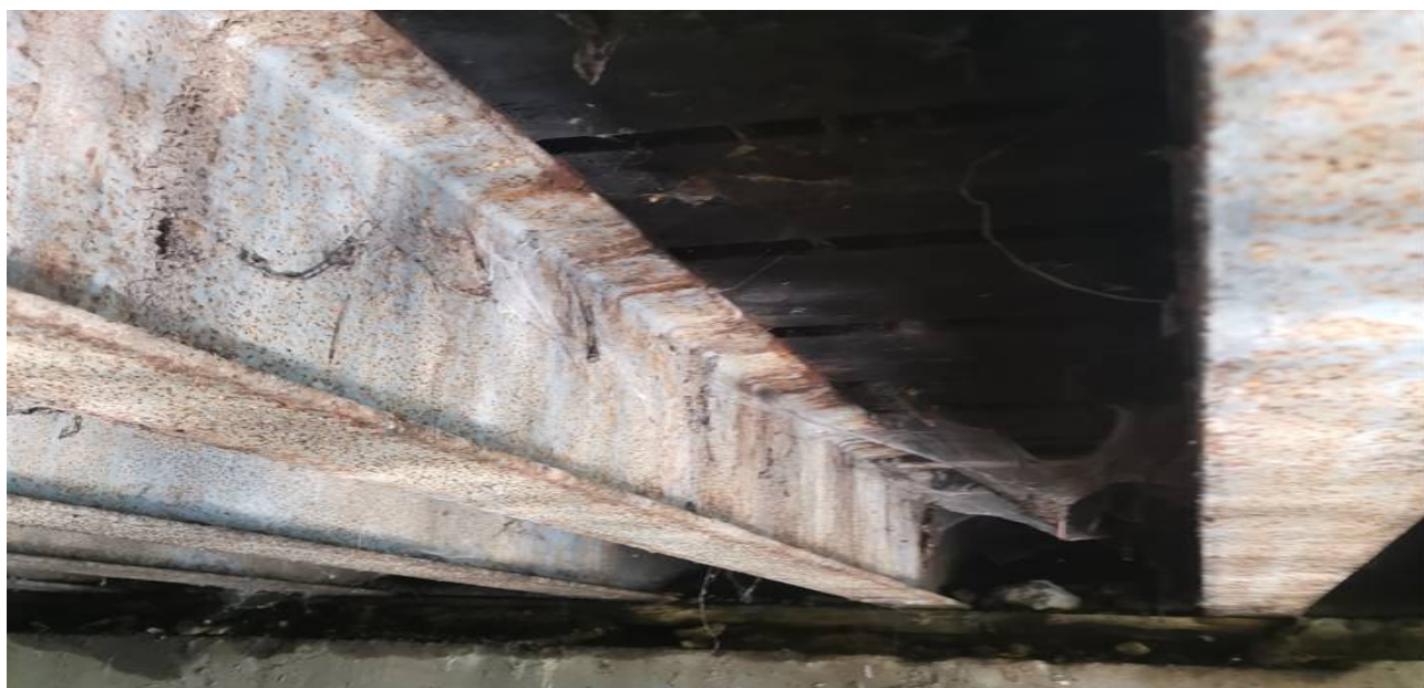
Rys. 3.1 Widok od spodu konstrukcji
