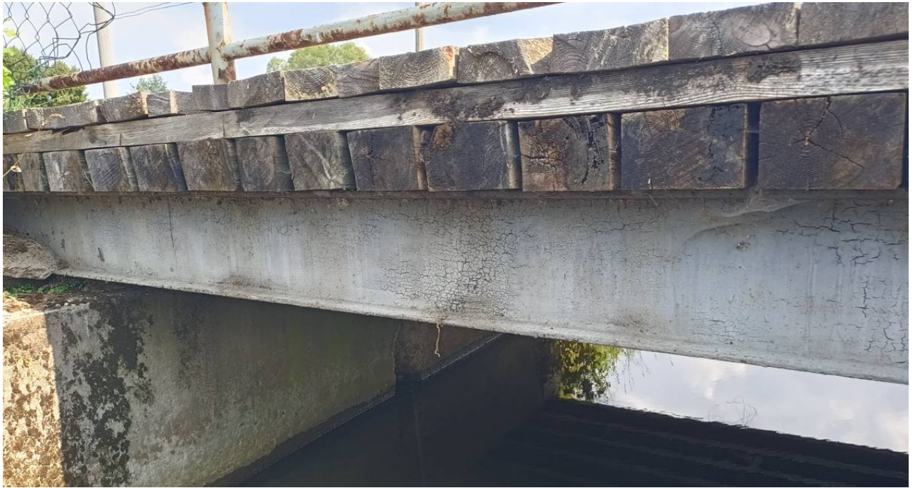
Rys. 3.4 Widok z boku konstrukcji
