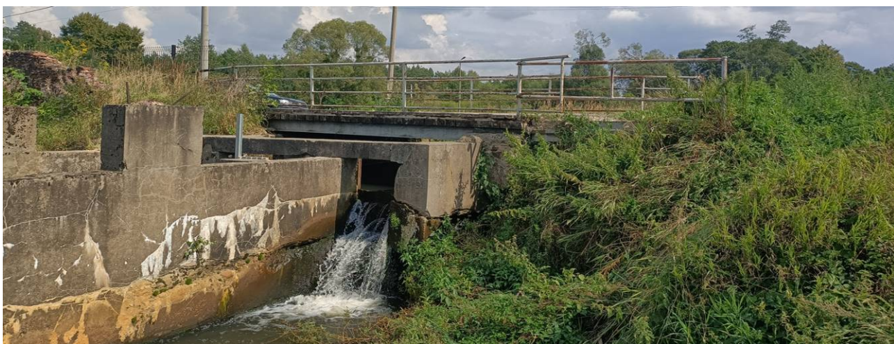
Rys. 1.2 Widok od strony wody dolnej istniejącego mostu
