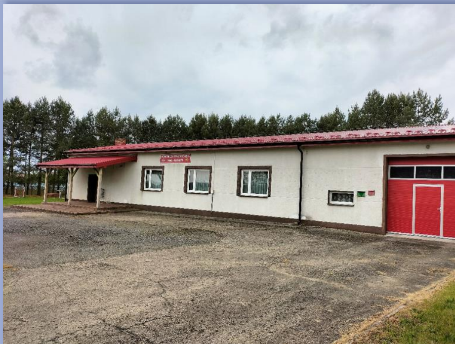
Rysunek 6. Wymiana pokrycia dachu na budynku OSP Janiki
