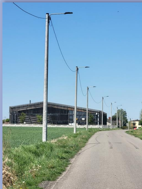
Rysunek 2. Oświetlenie ul. Ogrodowa od Hali Sportowej do bloków
