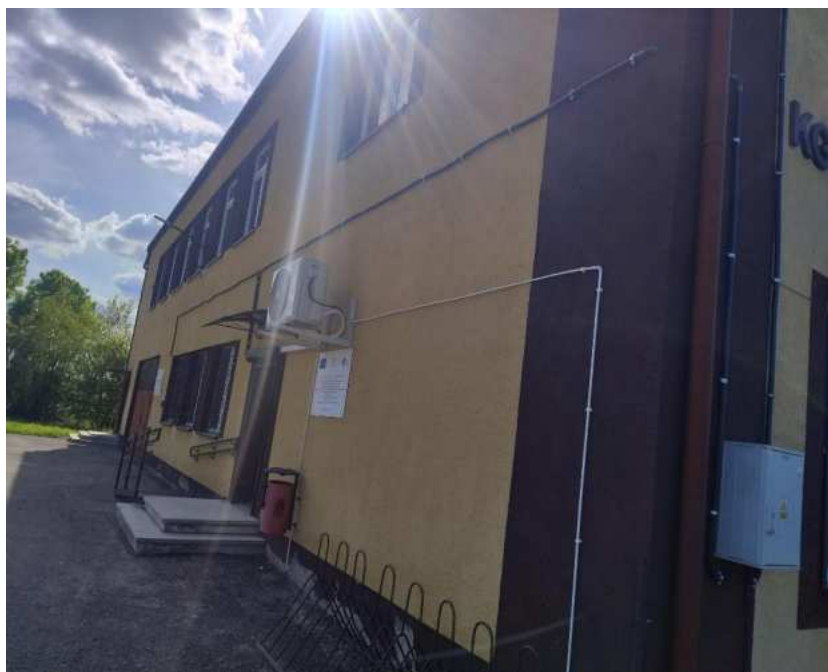
Przebudowa instalacji elektrycznej w OSP Kostrzyna
