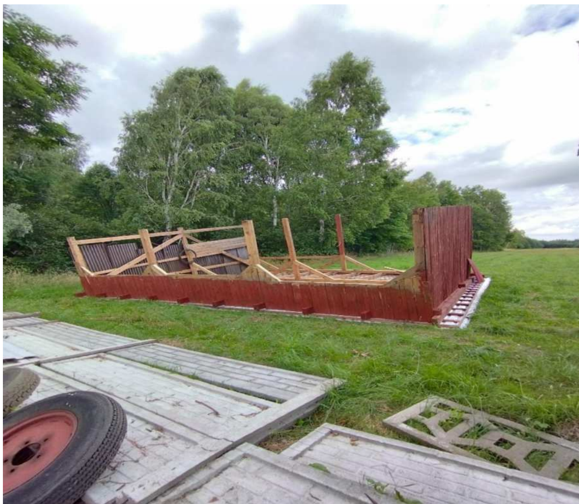
Zdjęcie przewróconego garażu i ogrodzenia podczas burzy w Kałmukach
