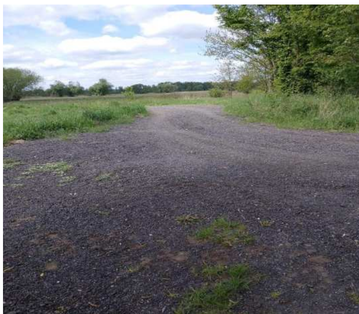
Utwardzenie dróg dojazdowych do pól w miejscowości Kostrzyna- Kotary
