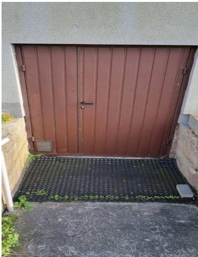
Zakup drzwi do kotłowni OSP Praszczyki
