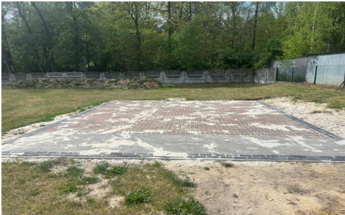
BUDOWA GARAŻU PRZY OSP KONIECZKI
